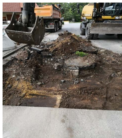
Aufbrucharbeiten Am Entenplatz Foto: Gemeinde Wagenfeld
