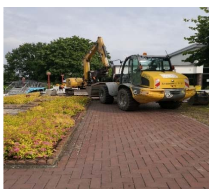
Arbeiten an dem Rohrschaden Foto: Gemeinde Wagenfeld
