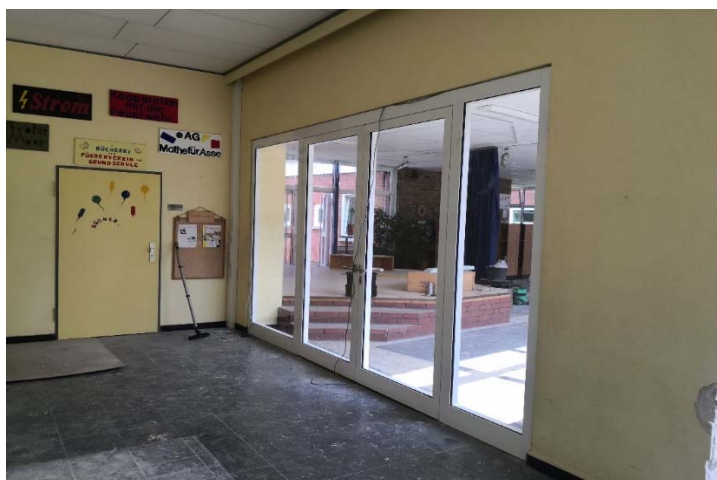
Neue Rauchschutztür Foto: Gemeinde Wagenfeld
