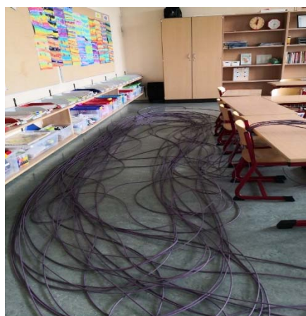
Verlegung der Verkabelung Foto: Gemeinde Wagenfeld
