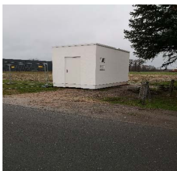
Neues Verteilergebäude Haßlinger Weg Foto: Gemeinde Wagenfeld
