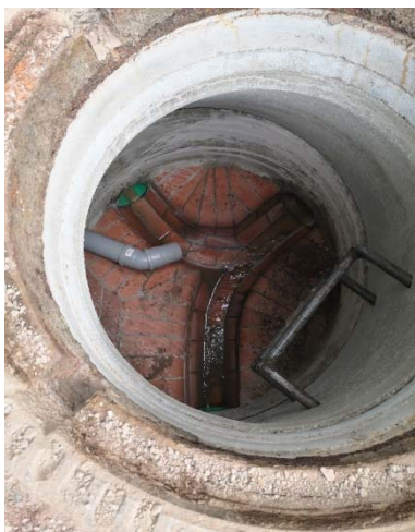
Neuer Schacht Foto: Gemeinde Wagenfeld
