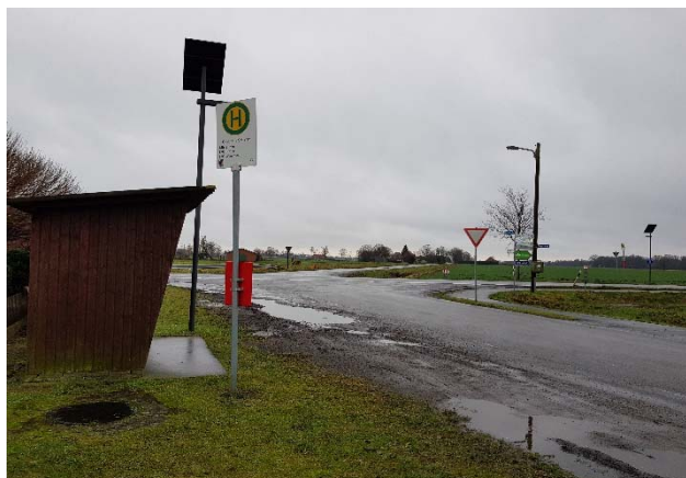
Neue Solarleuchte Foto: Gemeinde Wagenfeld
