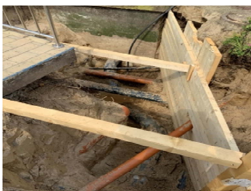
Offene Baugrube Foto: Gemeinde Wagenfeld
