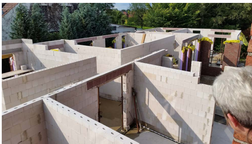
Baufortschritt im Sommer 2017
