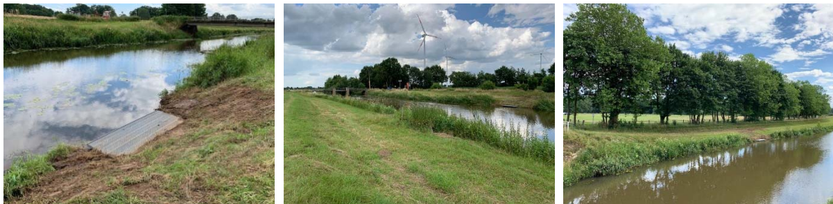
Neue Kanu-Anlegestellen nahe Diekstraße, Tierpark und Hespos Wehr Fotos: Gemeinde Wagenfeld
