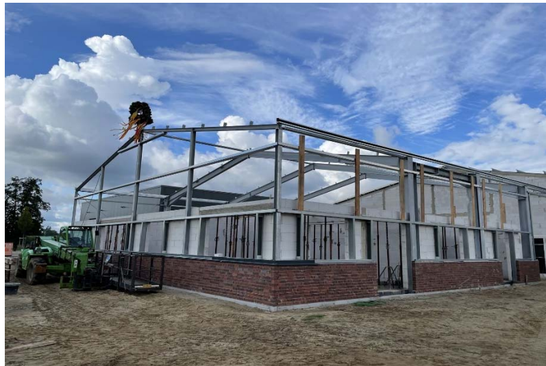
Richtfest Foto: Gemeinde Wagenfeld
