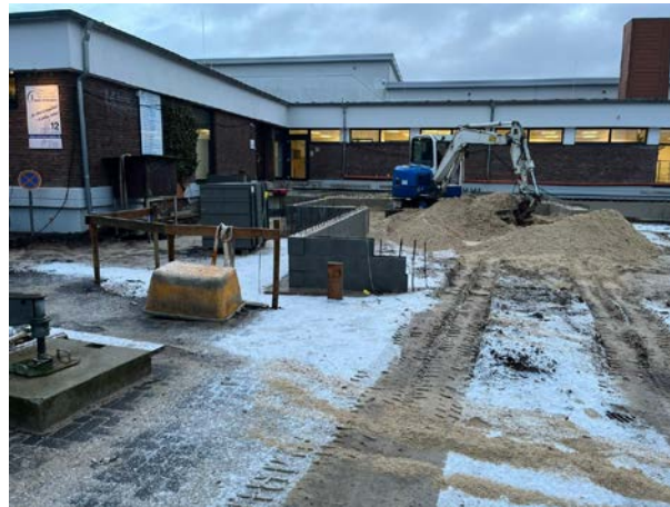
Umbau Praxis Pohlmann Foto: Gemeinde Wagenfeld
