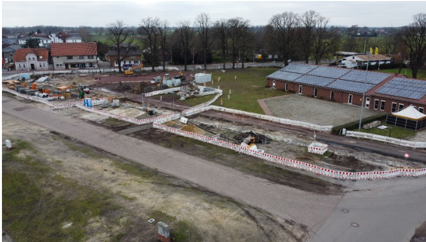
2. Bauabschnitt: Sanierung der Straße „Am Markt“ und Herstellung Parkplatz Bushaltestelle, Quelle: Gemeinde Wagenfeld
