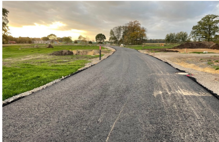
Erschließungsarbeiten Baugebiet. Foto: Gemeinde Wagenfeld
