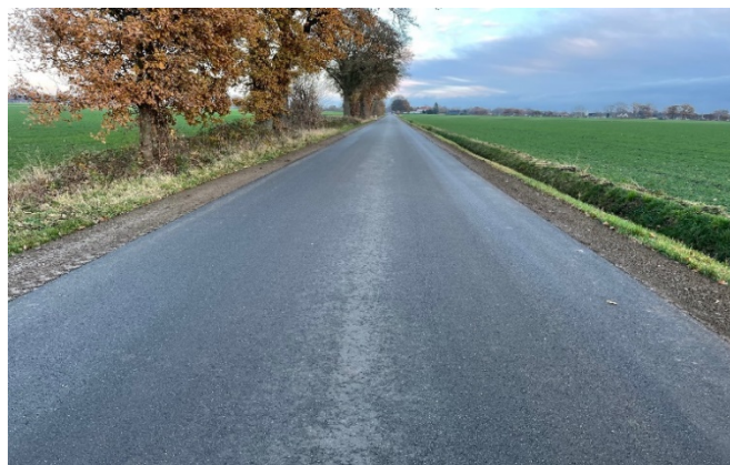
Instandgesetzter Seitenraum Neustädter Straße. Foto: Gemeinde Wagenfeld
