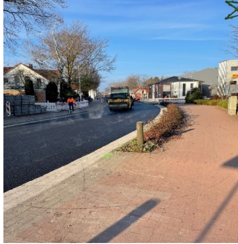
Sanierung B239. Fotos: Gemeinde Wagenfeld
