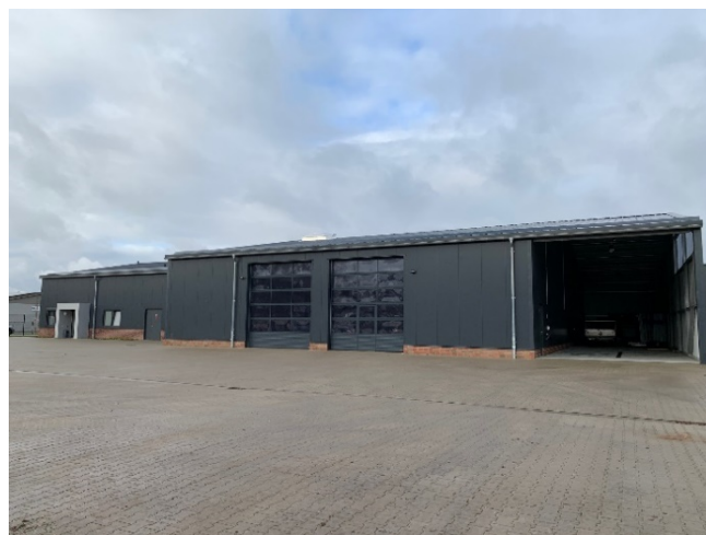
Neues Bauhofgebäude. Foto: Gemeinde Wagenfeld
