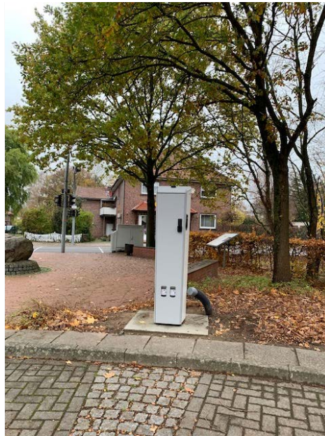
Eine der acht neuen Elektroladesäulen im Aufbau, hier am Dorfplatz Ströhen. Foto: Gemeinde Wagenfeld.
