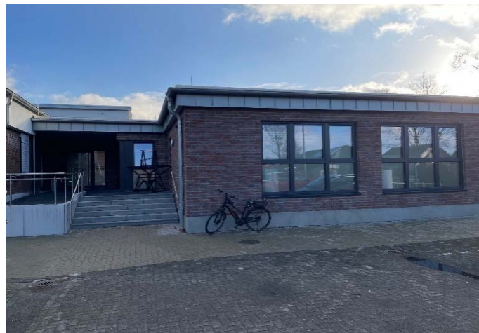
Foto: Gemeinde Wagenfeld, Neubau/Anbau
