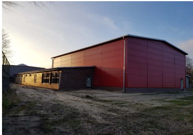
Außenansicht Sporthalle Foto: Gemeinde Wagenfeld
