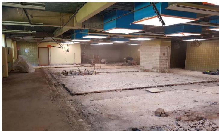
Rückbau Umkleiden Foto: Gemeinde Wagenfeld
