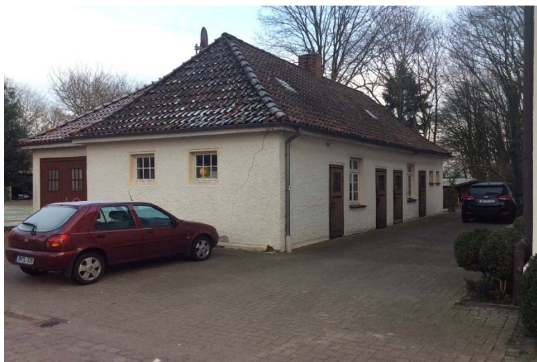
Aufenthaltsgebäude Mitarbeiter Foto: Gemeinde Wagenfeld
