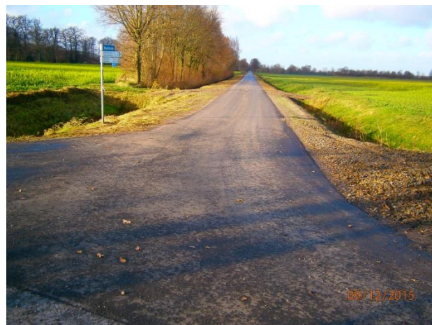
Bleckriede – 1.540 m mit BITU-Decke
