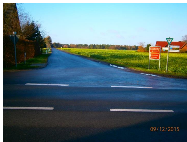
Langer Berg – 1.430 m mit BITU-Decke (von 'Varreler Straße' bis 'Jägerweg' in 3,5 m Breite)
