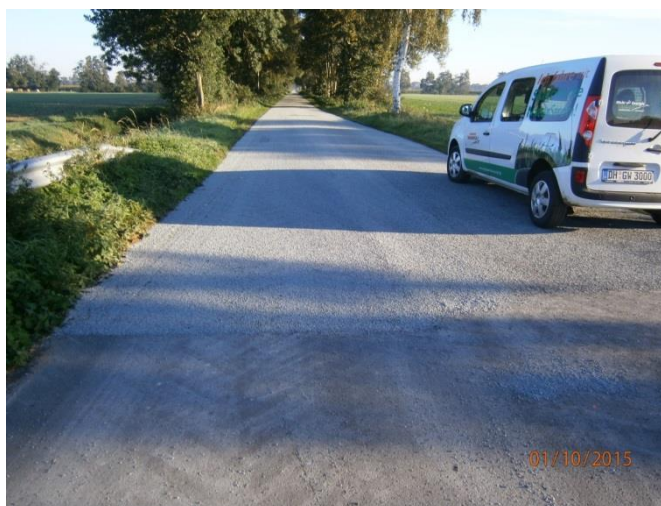
Am Gottesgraben Höhe Zufahrt zur Burlager Straße
