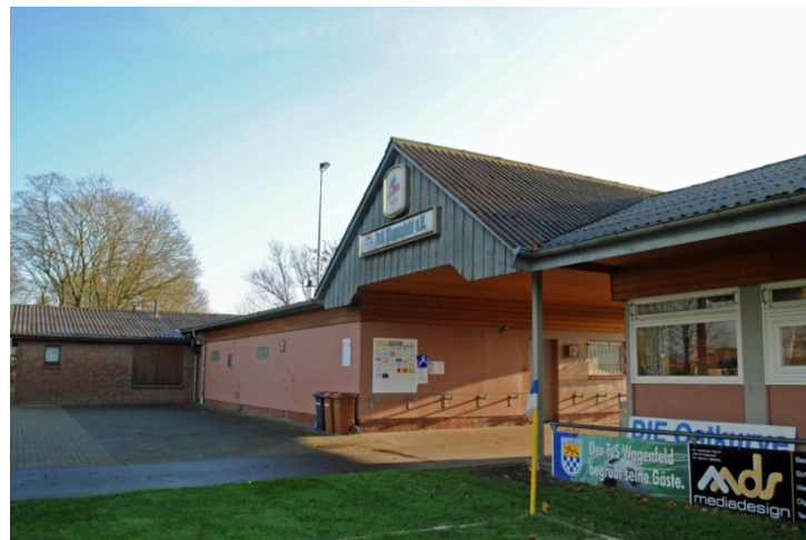
Die Umkleiden (links) auf dem Sportplatz in Haßlingen werden erweitert und saniert und in einem zweiten Bauabschnitt der Mehrzweck- und Fitnessraum (rechts) grundrenoviert.
