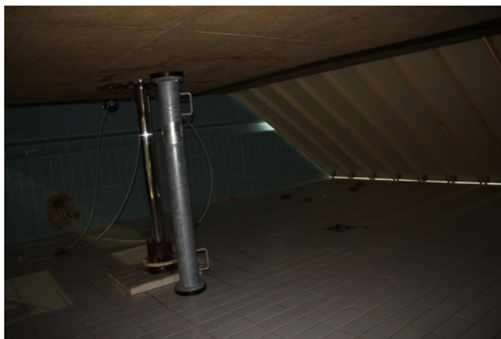
Blick unter den Hubboden im Hallenfreibad – Foto: Gemeinde Wagenfeld
