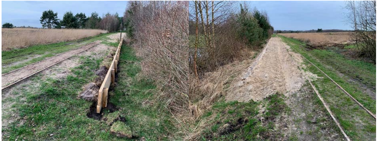
Einbau von Spundwände am Moorbahndamm. Fotos: Gemeinde Wagenfeld
