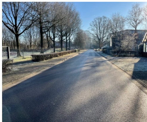
Saniertes Teilstück Hundeort Foto: Gemeinde Wagenfeld
